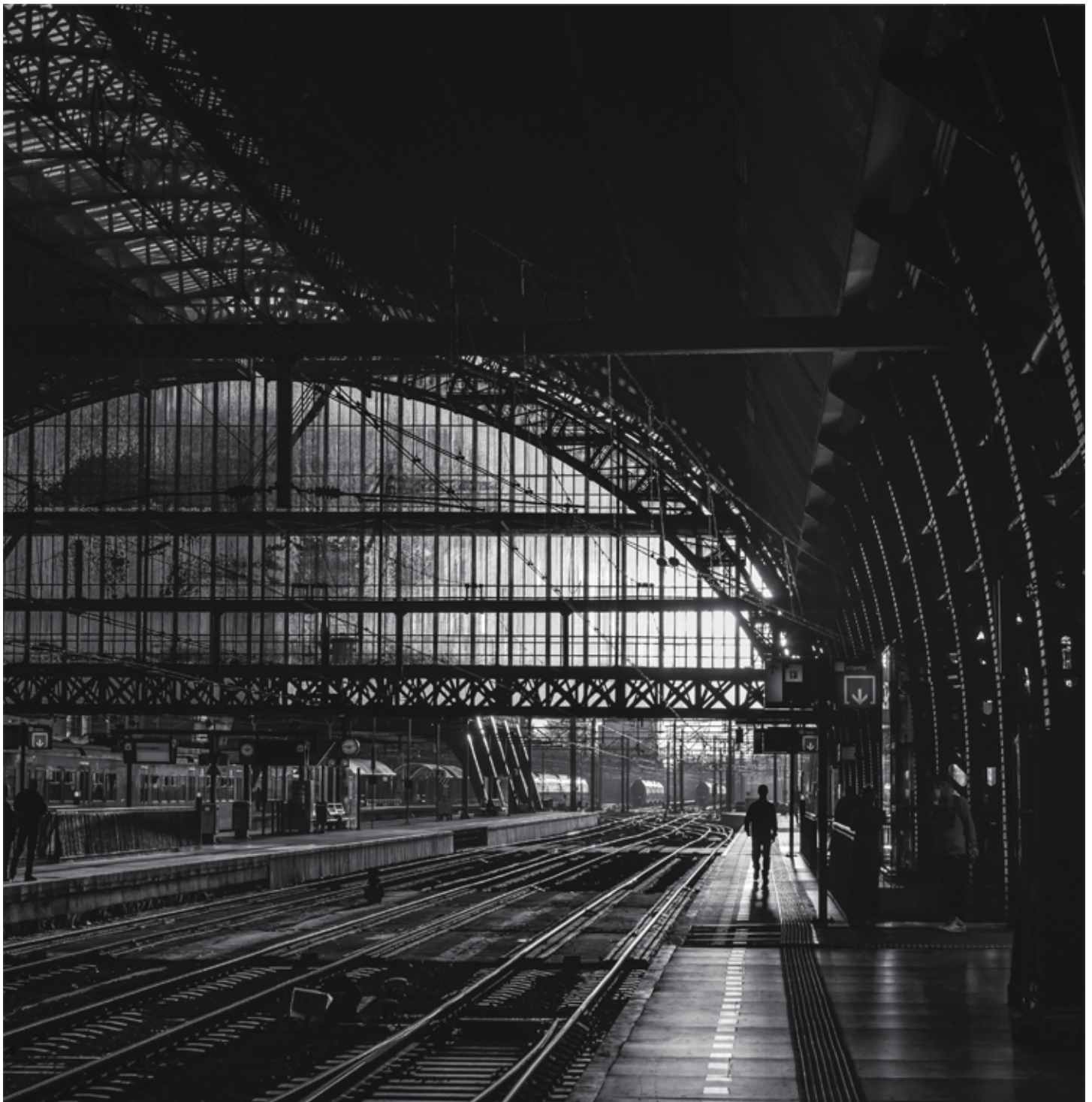
Estación ferroviaria italiana
